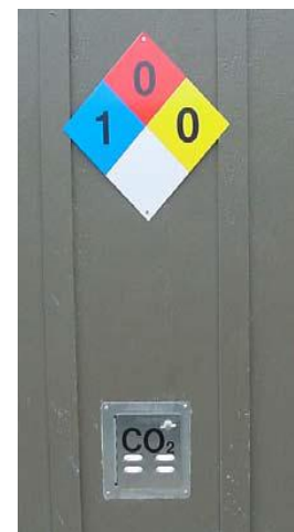
Exterior NFPA 704 Sign
